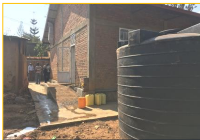
雨水タンク設置の様子
