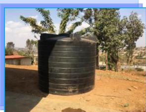
ルワンダは断水の期間も長く、水道から水が出ないことも多くあります。長年の課題であった水の衛生管理を改善するため、給食室で使用する貯水タンクの設置を昨年8月に行うことができました。一度断水が起こってしまうと、長時間の断水が続き、手が洗えない、トイレの水が流せない、などのトラブルが起きていましたが、雨水を貯めて利用する貯水タンクを設置したおかげで、学園の給食室の水の衛生環境問題の改善につなげることができました。貯水タンクの水を使って、調理用の水を確保でき、遠くへ水汲みに行く苦勞が緩和され、なおかつ調理室の水回りの清潔・衛生管理にもつなぐことができました。
