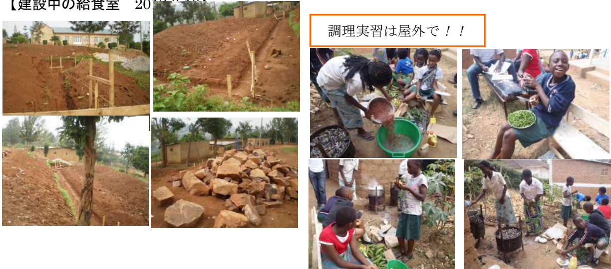
【建設中の給食室 2012.6.16】
